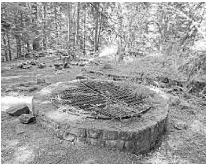
Auch die letzten Reste der Willenburg mit dem Tiefbrunnen werden im Verlauf der Wanderung besichtigt.
